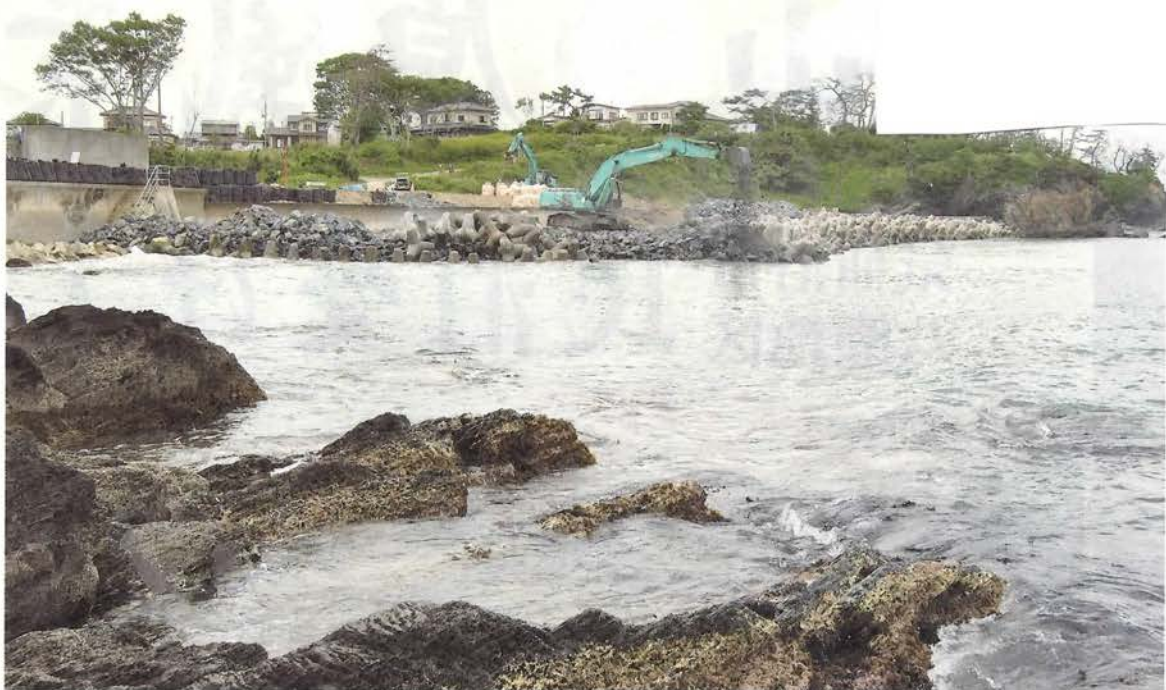
海抜9・8級の防潮堤工事が進む野々下海岸。ここには地元の 人に親しまれた砂浜があった
